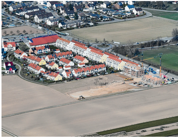
Das „Langweid Village“ aus der Luft: Zwei Mehrfamilienhäuser sind schon im Bau (rechts Mitte). Daneben sollen in den kommenden Monaten Doppelhäuser und Reihenhäuser entstehen.
